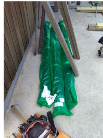
プレカット配管
