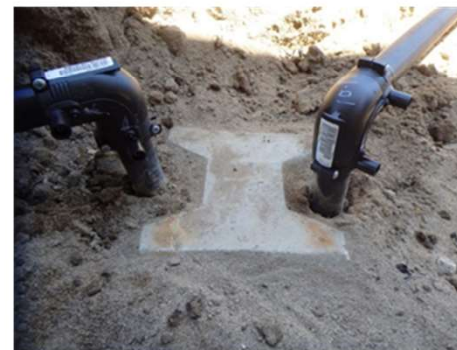
電気融着後の配管とPC杭
