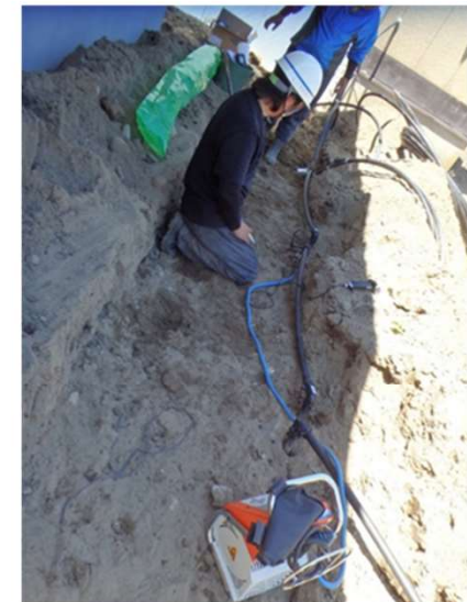
配管の電気融着
