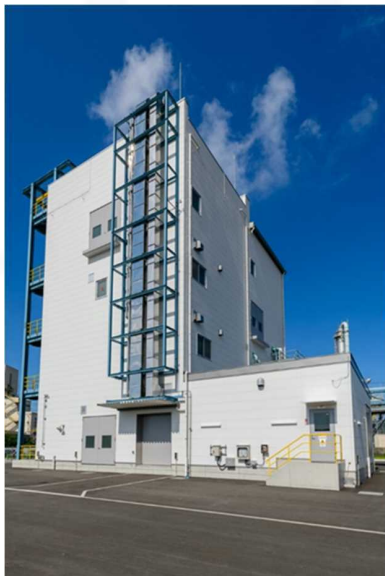
新規建設開発棟
