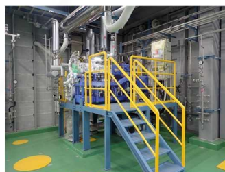
紡糸開発設備
