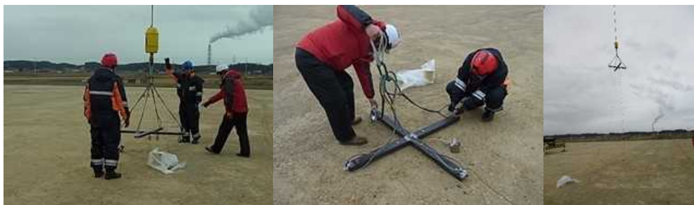
図 2. 1. 1. 7-25 クレーンによる落下準備
