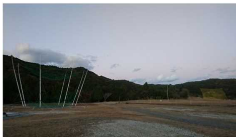
図2.1.1.7-384 ホーベック鳥羽工場に設置された 大型無人航空機落下受止装置（左）と無人航空機用落下受止装置（水平飛行からの落下受止装置）（右）
