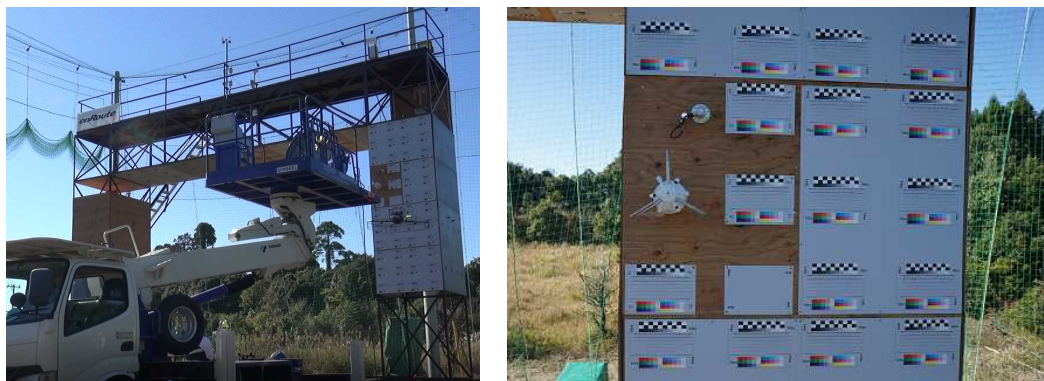
図 2.1.1.2-121 実験状況（左：全体画像、右：高橋脚撮影方向画像）
