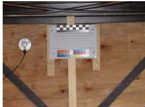
図 2.1.1.2-40 トラス越しの撮影例 (手前のトラスを避けて撮影した場合)
