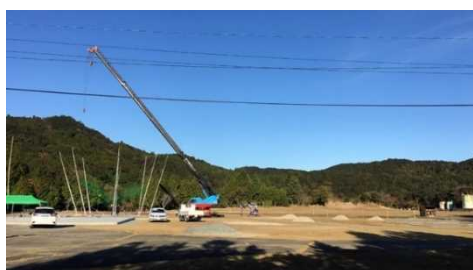
図 2.1.1.7-197 ホーペック鳥羽工場 敷地内
