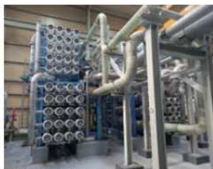
省エネルギー型海水淡水化システムプラント (サウジアラビア)
