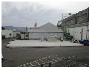
主要機器据付前 敷地全景
