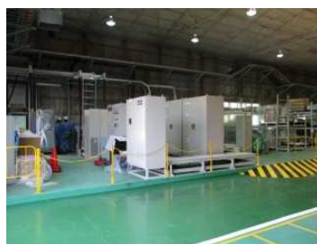
屋内設備設置状況
