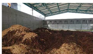
原料投入ウォーキングフロア
