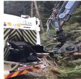
グラップルでの直接投入
