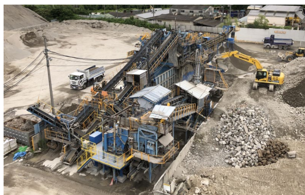
廃コンクリートを粉砕
