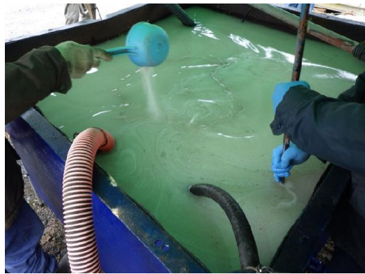
泥水タンクに珪砂を少量ずつ投入
