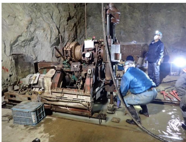
ボーリングマシン
