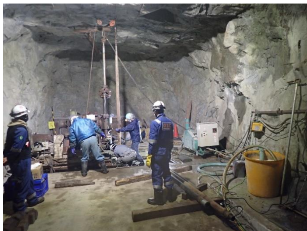
試験サイトの全景(被り550m)
