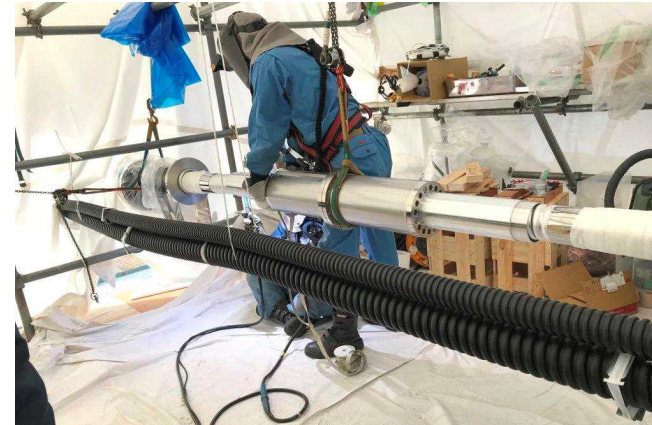
中間接続 組立状況
