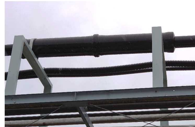
中間接続 布設状況
