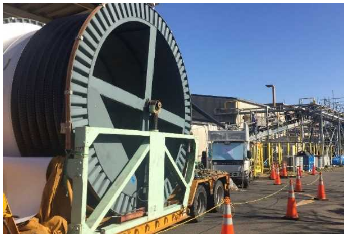
ケーブル延線前
