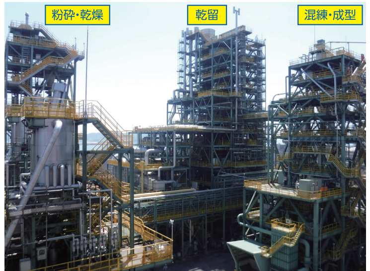
図2 中規模設備 (300t/d) 全景
