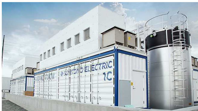
米国加州サンディエゴに設置したレドックスフロー蓄電池
