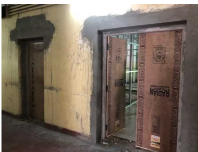
エネセンルーム入口 (リノベーション工事中)
