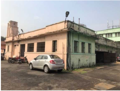
エネセンルーム外観（改修前）
