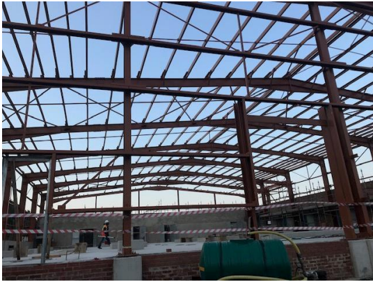
鉄骨建屋建設中
