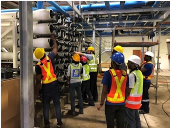
膜ユニット据付作業
