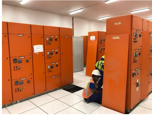
電気盤工事中
