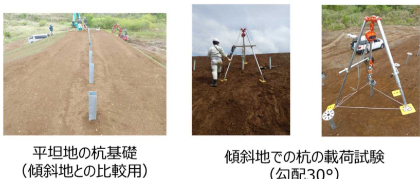
図Ⅲ-2-(ロ)-(i)-F-2 傾斜地での載荷試験の様子
