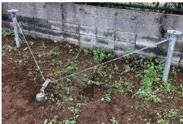
図Ⅲ-2-(ロ)-(i)-D-1 杭補強の施工事例
