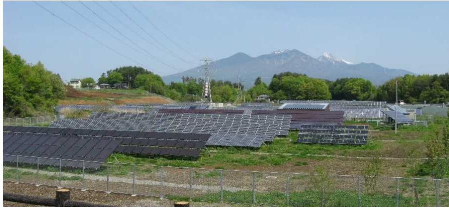
図Ⅲ-2-(ハ)-(ii)-B-3 北杜メガソーラー発電所
