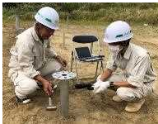
図Ⅲ-2-(ロ)-(i)-D-4 打音による支持力判定の様子
