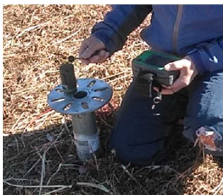
図Ⅲ-2-(ロ)-(i)-D-5 打音による杭長、支持力判定の様子
