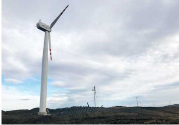
設置した風力発電機の様子
