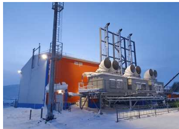
建設した発電所建屋の外観
