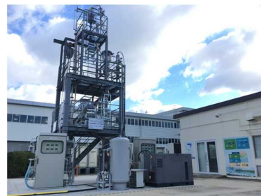
写真：大阪ガス(株)「Carbon Neutral Research Hub」の見学ルートに入っているケミカルルーピング大型コールドモデル
