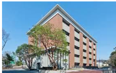
北部総合教育研究棟 (地下1Fに培養装置群を設置)
