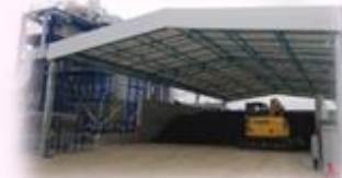
燃料投入ワーキングフロア
