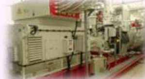
ORC熱電併給設備
