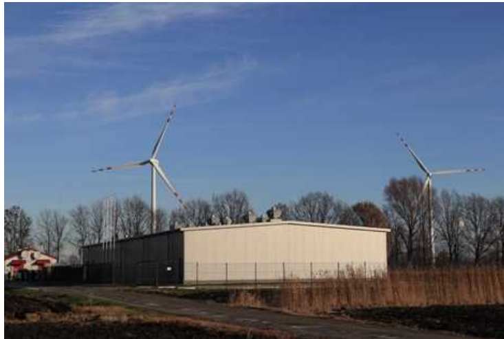
ビストラ風力発電所に併設したハイブリッドBESS建屋
