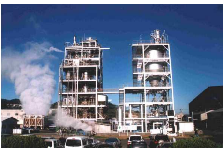
50TPD炉試験設備
