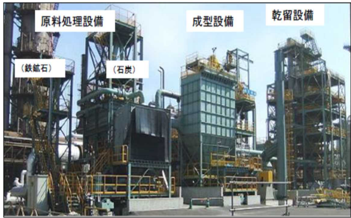
30t/dパイロットプラント全景
