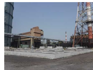
基礎工事(コンクリート4,600m3)
