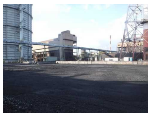
撤去工事後(更地)
