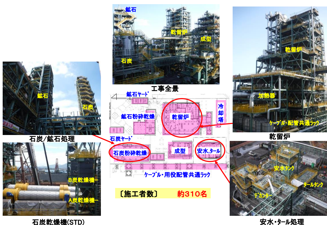
図3-3 300t/dフェロコックス製造中規模設備 工事全景
