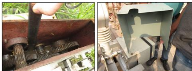
図 20:漏水したギアボックス内部 (左) と防水カバー (右)
