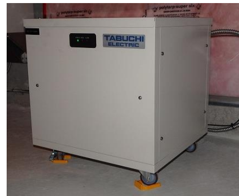
図8 蓄電池ユニット
