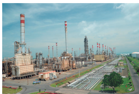
図10 ● 運用最適化技術を導入した製油所の動力プラント (インドネシア)
