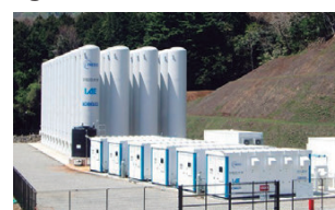
図31 ● 発電量の予測情報に基づく制御技術を用いた圧縮空気エネルギー貯蔵 (CAES: Compressed Air Energy Storage) システムの実証施設
