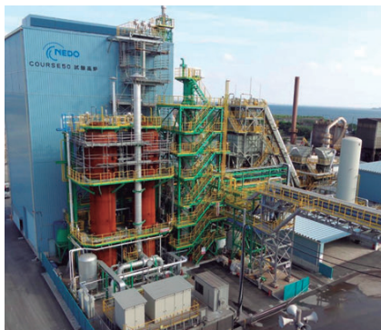
鉄鋼業界でもCO 2 削減の取り組みが盛んに。鉄鉱石還元剤であるコークスの一部を水素に代えるプロジェクト「COURSE50」の試験高炉で検証を推進 提供：日本製鉄
