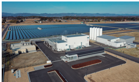
「水素社会」実現に向けP2G実証施設を建設した「福島水素エネルギー研究フィールド(FH2R)」
