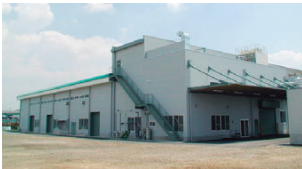
図7 ● 量産プラント設置予定の三井化学名古屋工場内の建屋
