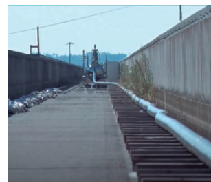
図18 ● ケーブル敷設状況（宮崎リニア実験線跡地）
