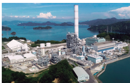
図3 ● 大崎クールジェンデモンストラーションプラント、大崎クールジェン(広島県大崎上島町) 石炭処理量 1,180t/日
