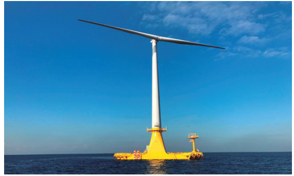
風力発電の可能性を広げるため水深の浅い海域で設置可能なバージ型風力発電システムを北九州市沖に設置
