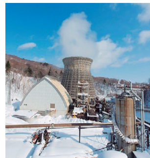
図26 ● 松川地熱発電所(岩手県)
