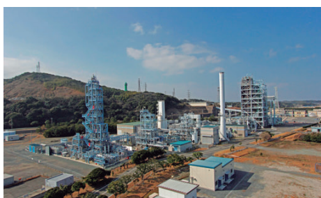
図2 ● EAGLEパイロット試験設備、電源開発 (北九州市) 石炭処理量 150t/日
