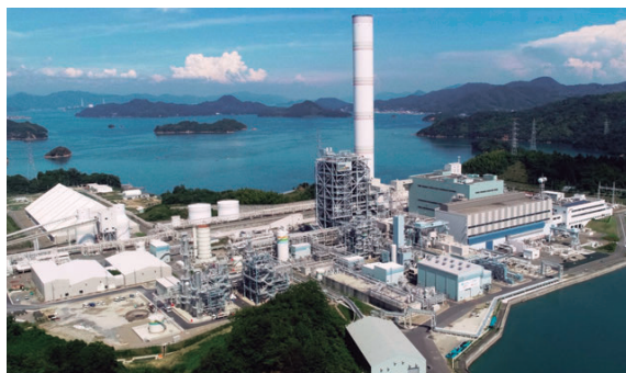
石炭火力発電から排出されるCO 2 を大幅に削減できる、広島県大崎上島町にあるIGCCの実証プラント 提供：大崎クールジェン
