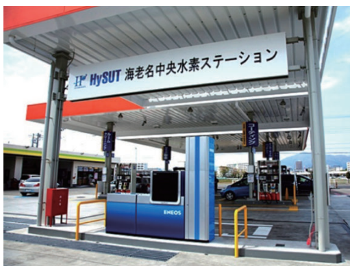
燃料電池車の普及に向け建設された、ガソリンスタンドと一体型の水素ステーション「海老名中央水素ステーション」
