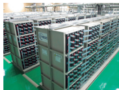
図9 ● 日立製作所・昭和電工マテリアルズが開発した鉛蓄電池-LICハイブリッド蓄電システム
