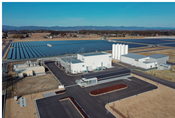
図4 ● 完成した福島水素エネルギー研究フィールド (FH2R)
