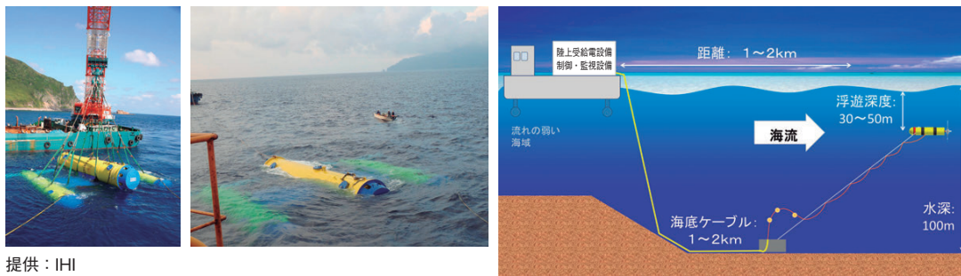
図17 ● 口之島沖に設置中の100kW級水中浮遊式海流発電実証試験機及び、2017年度実証試験の概要
