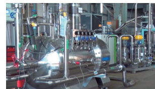
図17 ● ケーブル端末（手前）と小型冷凍システム（後方）
