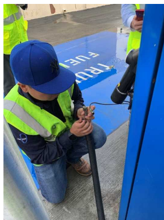
ホース取り付け作業
