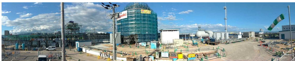
据付工事全景
