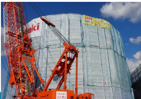
液化水素貯蔵タンク現地据付状況①
