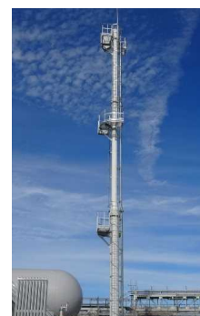
ベントスタック据付
