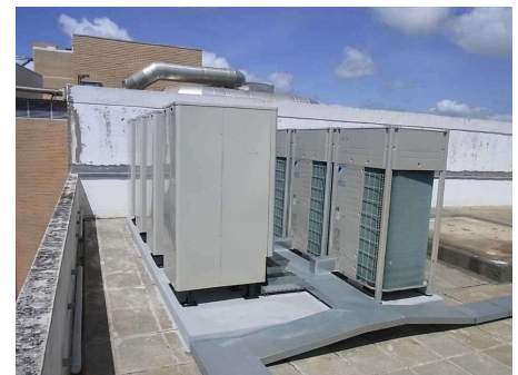
実証サイトに設置したVRV室外機と蓄冷ストレージ
