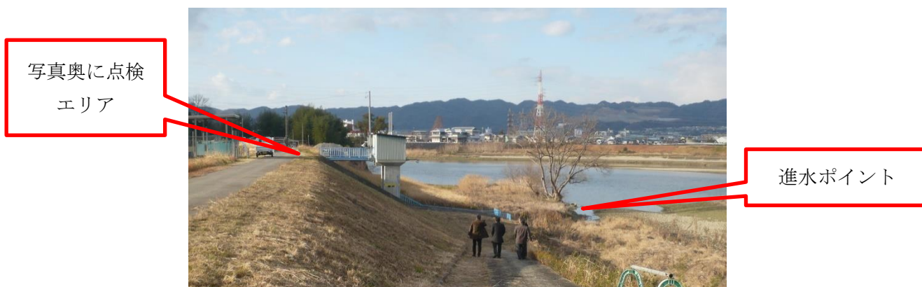
図Ⅲ2.1.1.3-1 点検エリアおよび進水ポイント
