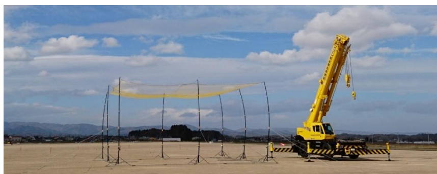
図Ⅲ2.1.1.6-17 ドローン落下受止装置とドローン落下用クレーン
