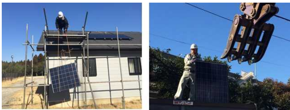
図Ⅲ-2-①-(2)-2 太陽光パネルの荷おろしの様子
