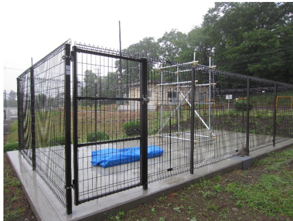
図 5.4(2)-16 実証試験用コンクリート基礎(43 地点)
