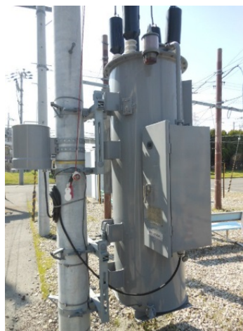
図 5.2-4 単柱への施設状況
