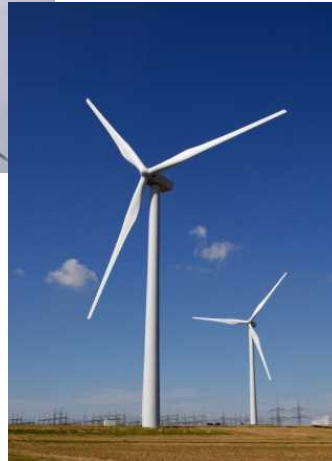
発電・コジェネシステム
