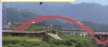
中国 過積載車両による橋梁の崩壊
