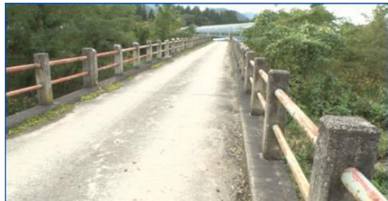
老朽橋梁の点検
