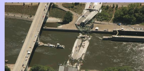
米国ミネソタ州ミネアポリス ミシシッピ川に架かる高速道路橋の崩落
