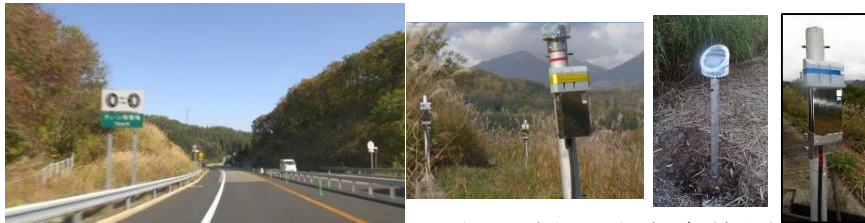
要注意法面の監視
