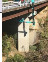
橋梁点検車とド ローンの連携運用
