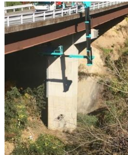
橋梁点検車と ドローンの連携運用
