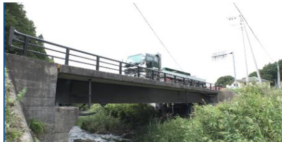
道路橋梁(郡山市)
