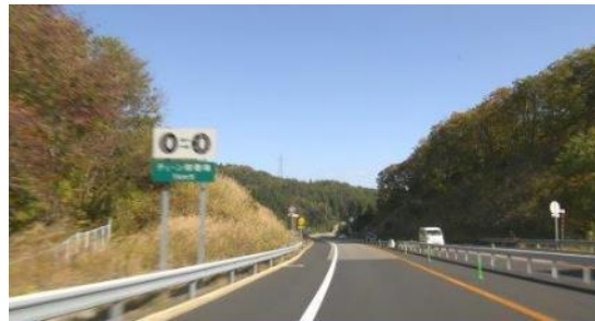
要注意法面の監視
