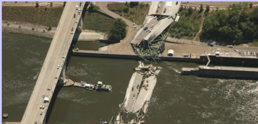
米国ミネソタ州ミネアポリス ミシシッピ川に架かる高速道路橋の崩落
