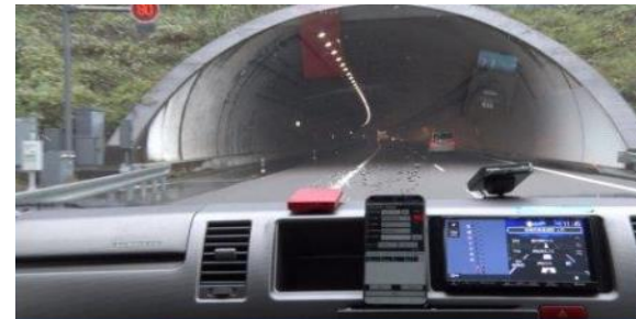
三岳山トンネル(新東名高速道路)
