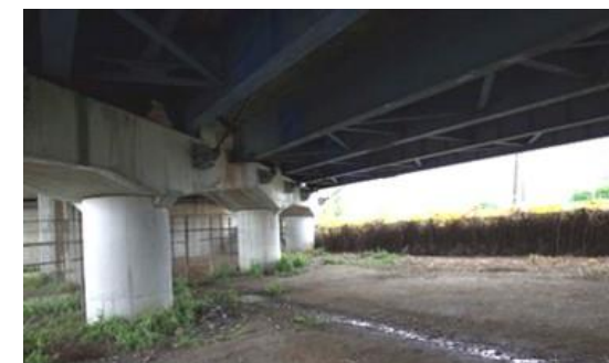
橋梁(西日本高速道路管内)
