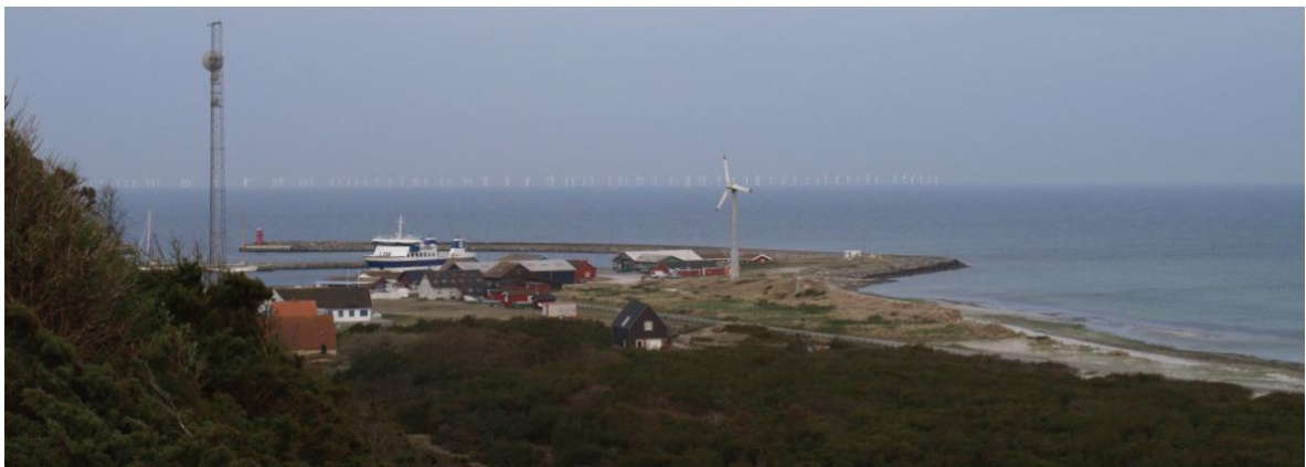
(建設後：2.3MW174基)
