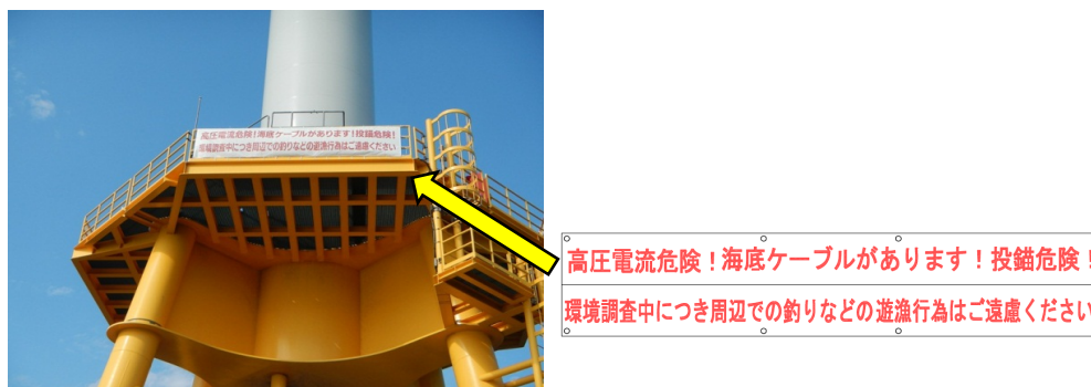
図 7.4-4 遊漁船に対する注意喚起看板の設置状況
