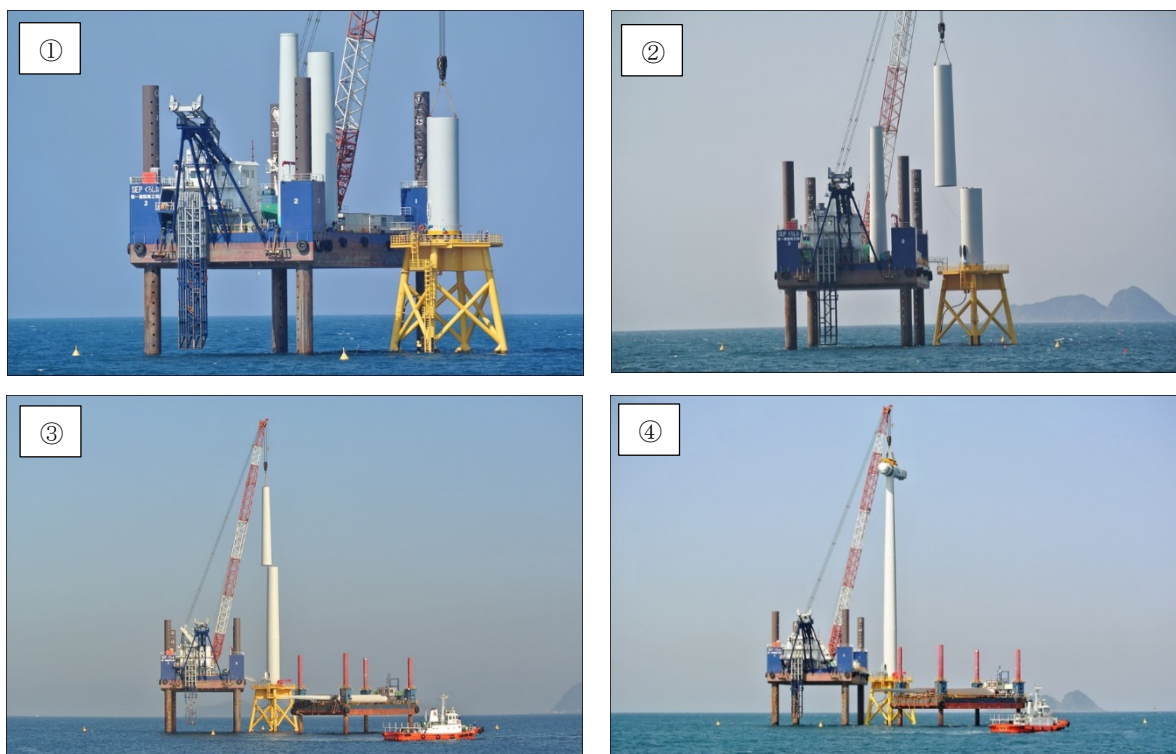
① ボトムタワー据付 ②ミドルタワー据付 ③トップタワー据付 ④一体型ナセル据付
