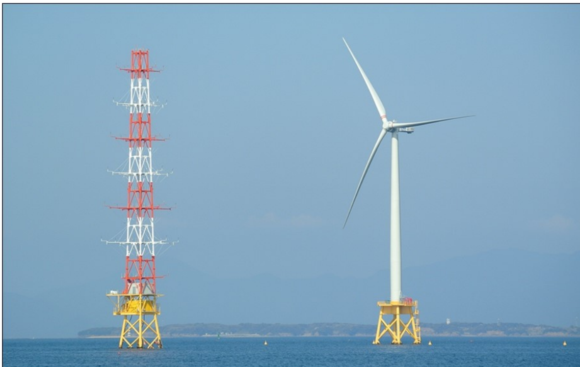
図 6.3-3 洋上風車の完成時の状況
