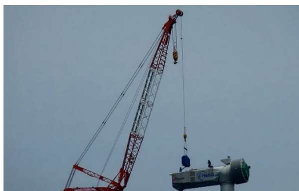
図 7.4-5 変圧器の交換作業
