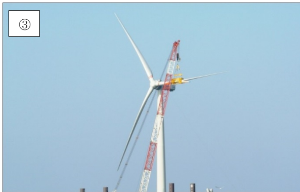
① ブレード No.1 据付 ②ブレード No.2 据付 ③ブレード No.3 据付 ④ブレード据付完了
