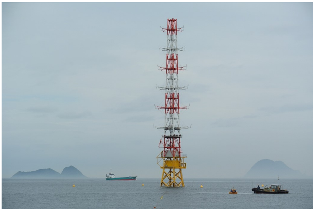
図 6.2-3 洋上風況観測タワーの完成時の状況
