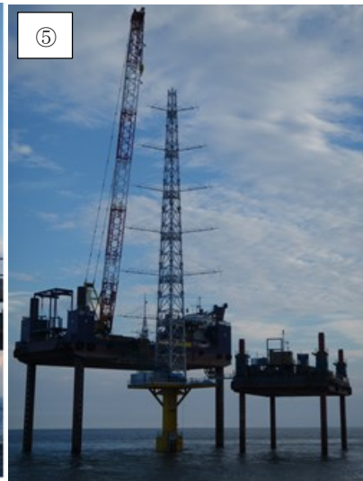
①SEP 船、設置完了 ②プラットフォーム設置完了、③タワー2,3 ブロックの設置 ④タワー5,6 ブロックの設置、⑤組立完了
