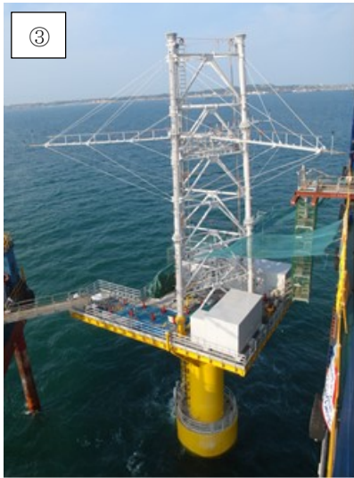
①SEP 船、設置完了 ②プラットフォーム設置完了、③タワー2,3 ブロックの設置 ④タワー5,6 ブロックの設置、⑤組立完了
