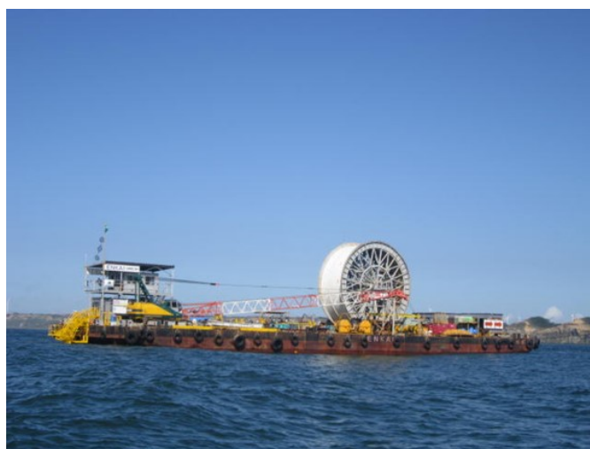
図 6.4-1 布設台船による海底ケーブル布設状況
