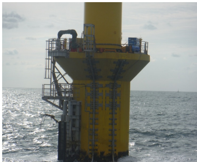
図 7.4-4 復旧工事終了後のケーブル保護管および固定架台の状況
