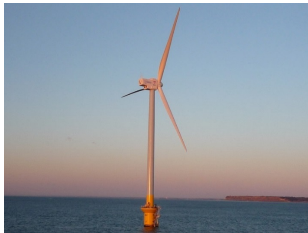
図 6.3-5 洋上風車の完成時の状況
