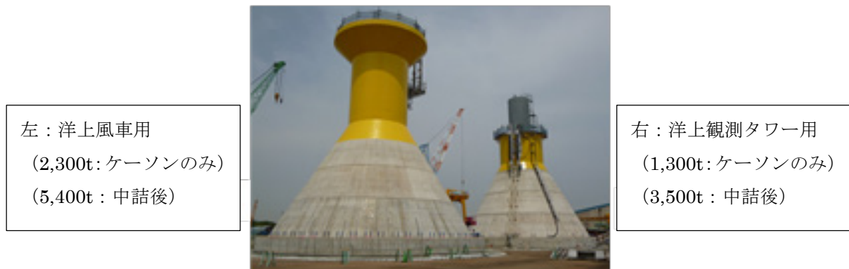
図 5.1-3 実際に製作された支持構造物
