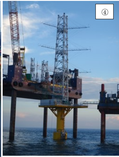
①SEP 船、設置完了 ②プラットフォーム設置完了、③タワー2,3 ブロックの設置 ④タワー5,6 ブロックの設置、⑤組立完了
