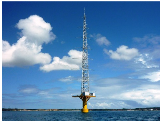
図 6.2-4 洋上風況観測タワーの完成時の状況
