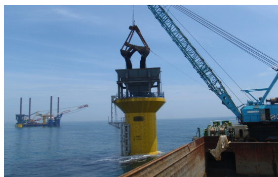
図 6.1-4 中詰材（銅水碎スラグ）の投入状況
