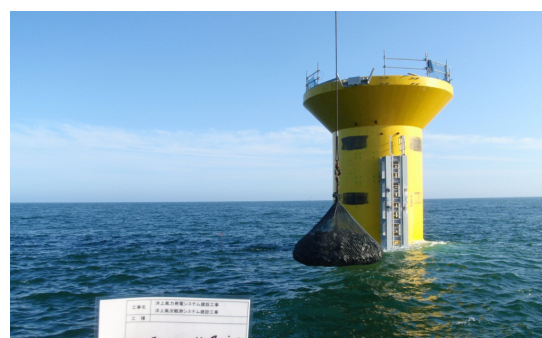
図 6.1-5 フィルターユニットの据付状況
