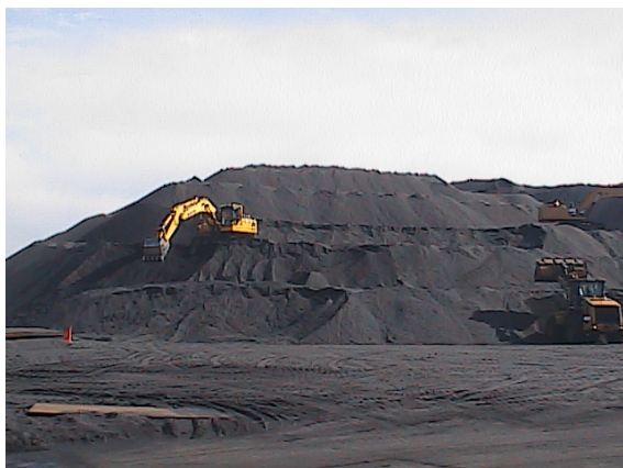
図 6.1-4 中詰材（銅水碎スラグ）の投入状況
