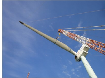
【ブレード据付】
