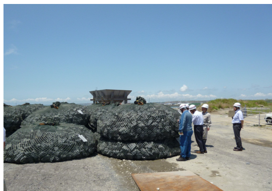
図 6.1-5 フィルターユニットの据付状況
