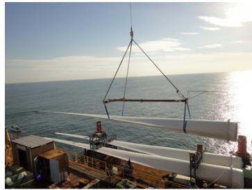
【ブレード吊り上げ】
