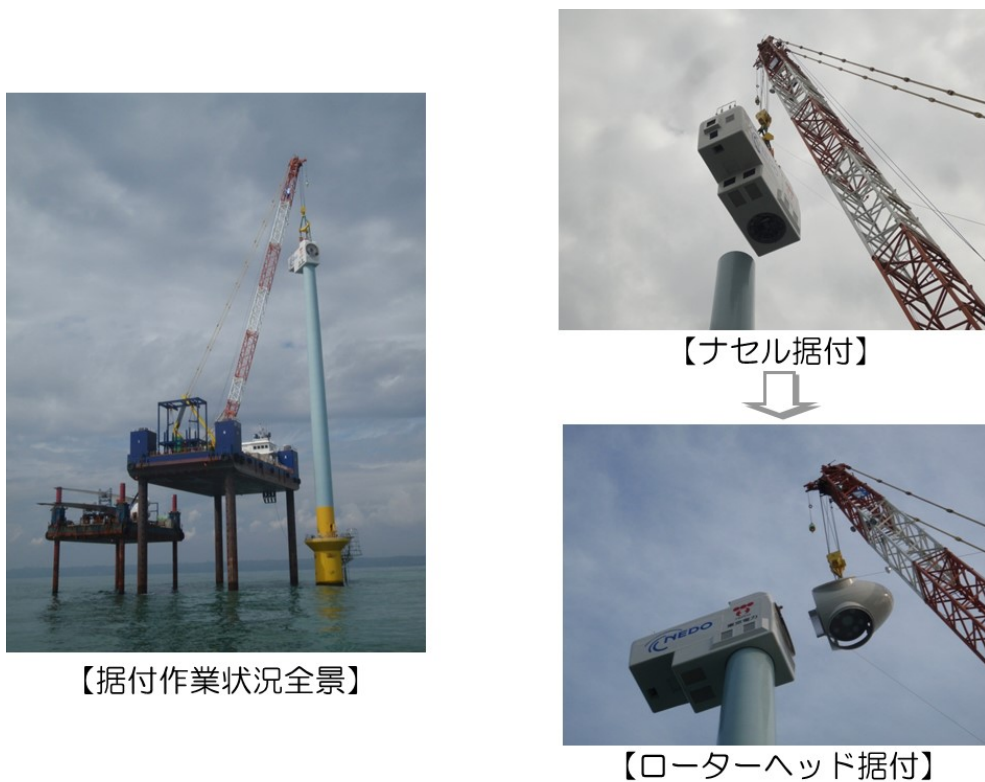
図 6.3-3 ナセル・ローターヘッドの据付状況
