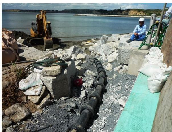
図 6.4-2 陸上部のケーブルの防護状況
