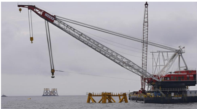
Block Island Wind Farm の建設状況（Smith et al. ,2015）
