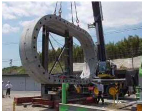
コンクリート浮体構造の試験体吊り上げ試験
