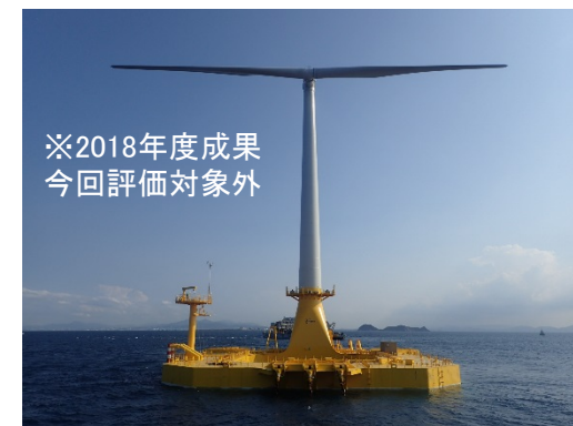
海域に係留接続完了した 浮体式洋上風力発電システム 「ひびき」
