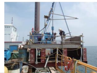
ボーリング調査
