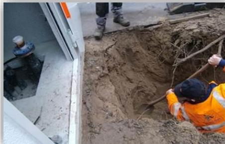
地中埋設配線工事
