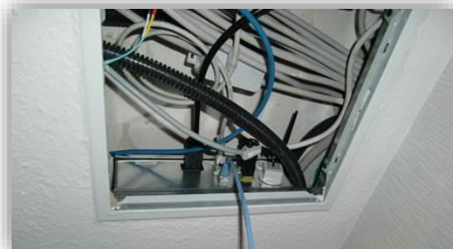
居住宅天井点検口
