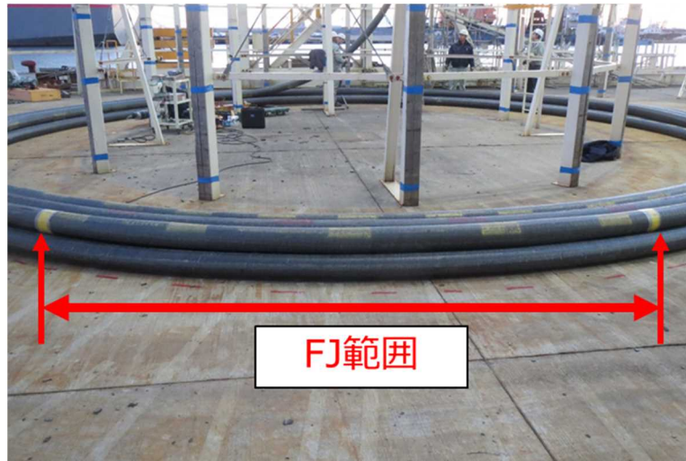
図 3-5-12 工場ジョイント外観
