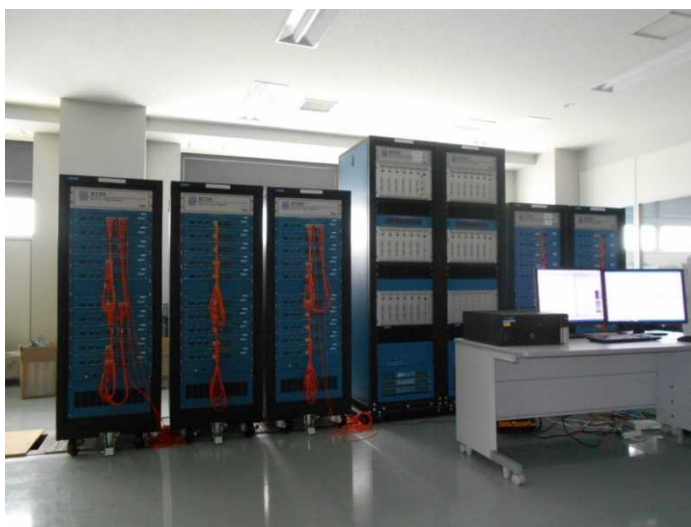
図 3-3-5 東電 HD 設置の RTDS
