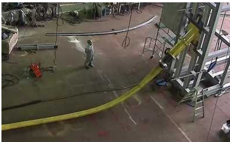
図 3-5-13 風車へのケーブル引込作業施工性確認試験状況
