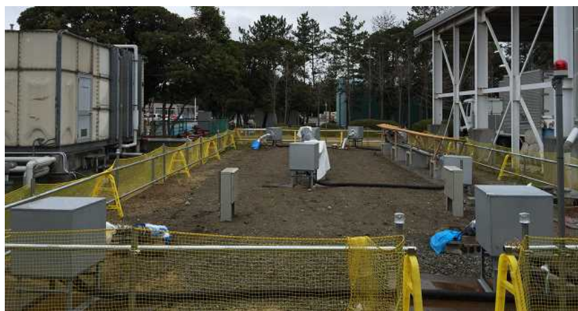
図 3-5-7 ケーブルを布設したフィールド
