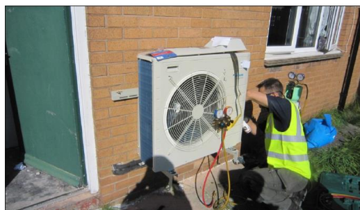
図7 室外機設置の様子
