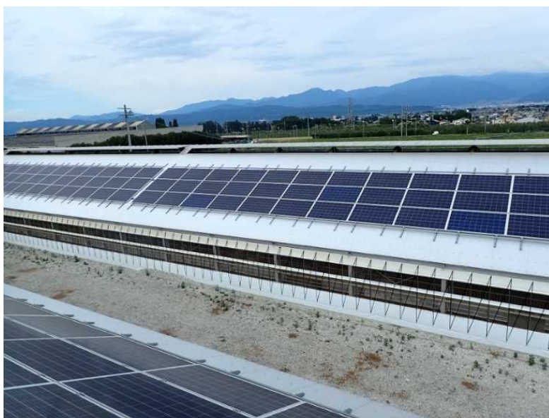
写真Ⅲ-2-①-3-8 追加設置を行った長野県豚舎（58.3kW）
