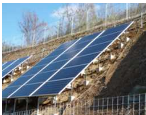
太陽電池モジュール設置後
