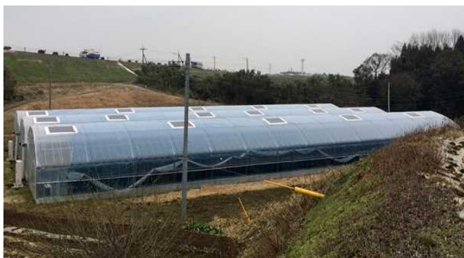
図Ⅲ-2-①-4-14 生産実証ハウス外観
