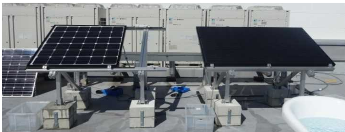
図Ⅲ-2-③-14-8 計測状況
