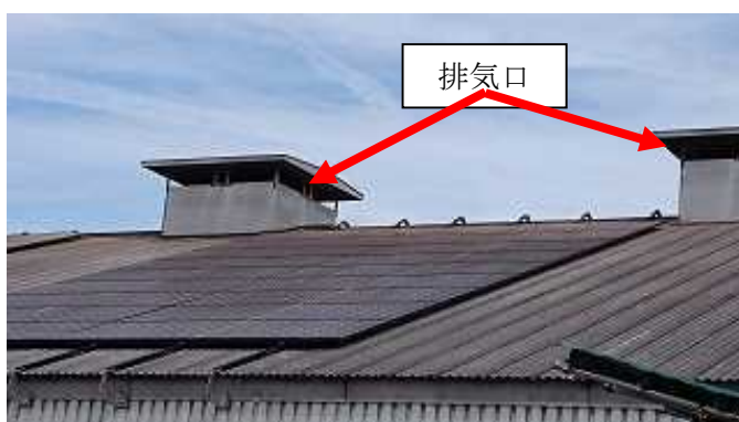
図Ⅲ-2-①-3-6 岩手県豚舎設置風景
