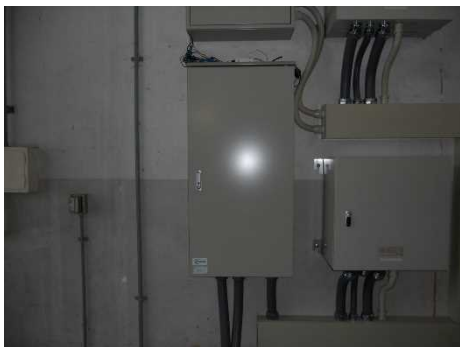
図III-2-①-8-22 直流集電箱
