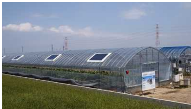
図Ⅲ-2-①-4-10 社内実証ハウス外観
