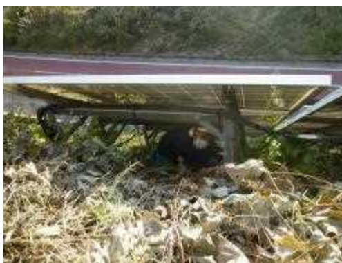
除草及び点検作業の状況
