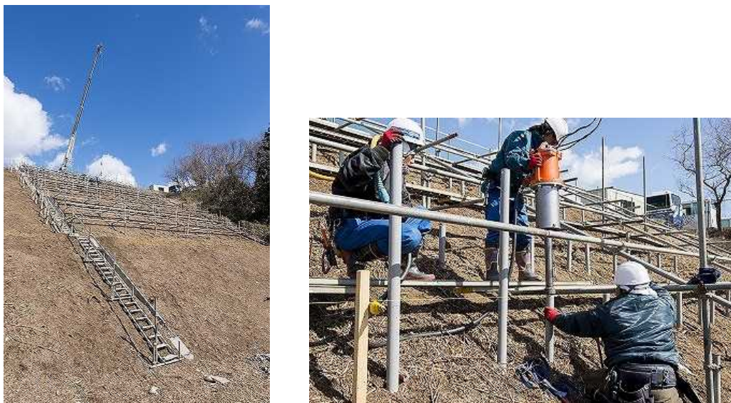
図Ⅲ-2-①-7-13 重機を使用した施工状況（従来工法の把握）
