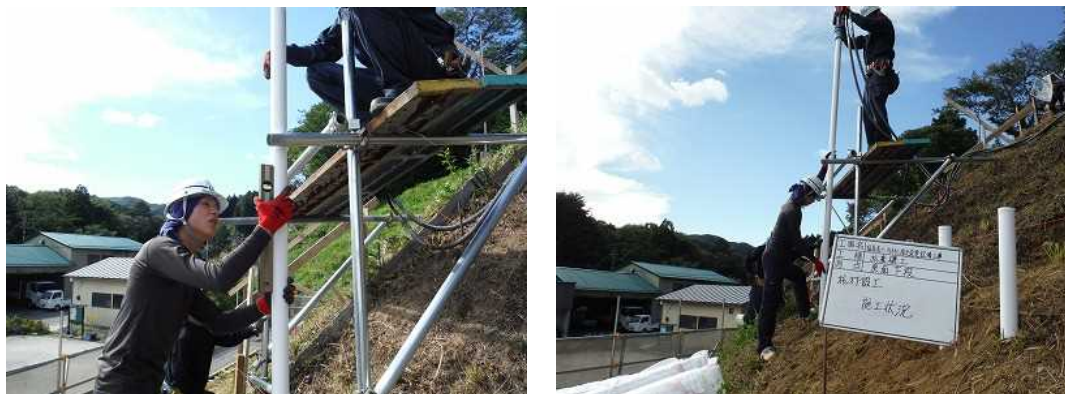
図Ⅲ-2-①-7-14 重機を使用しない施工工法
