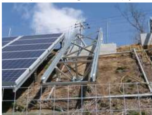
太陽電池モジュール設置前
