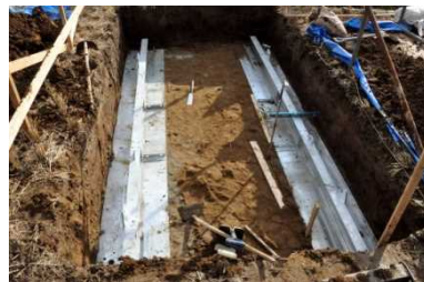
<架台基礎と地中梁>
