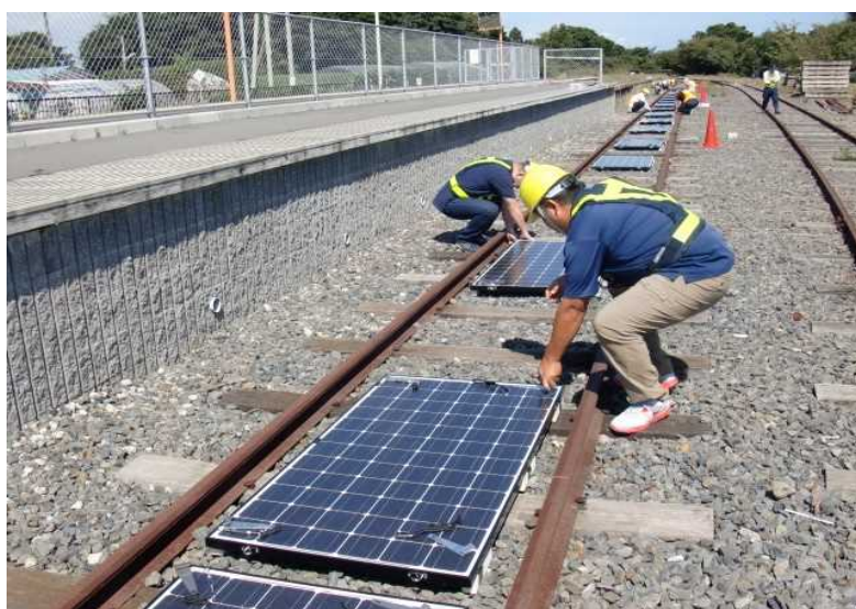
図Ⅲ-2-②-10-6 間隔を空けた場合に設置実験
