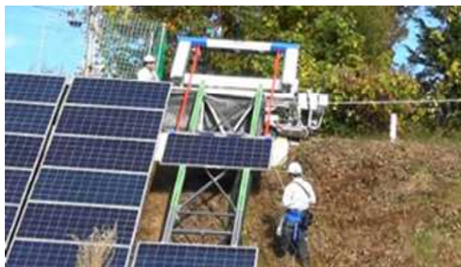
図Ⅲ-2-①-6-6 試作2号機による太陽電池モジュールの設置状況
