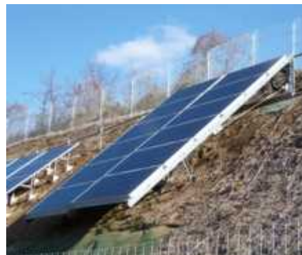
太陽電池モジュール設置後
