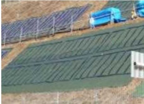
防草シート設置後 (太陽電池モジュール設置前)
