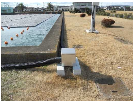
図Ⅲ-2-①-8-14 配管・配線②
