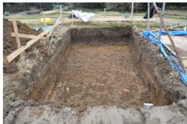
<地盤75cm掘削>
