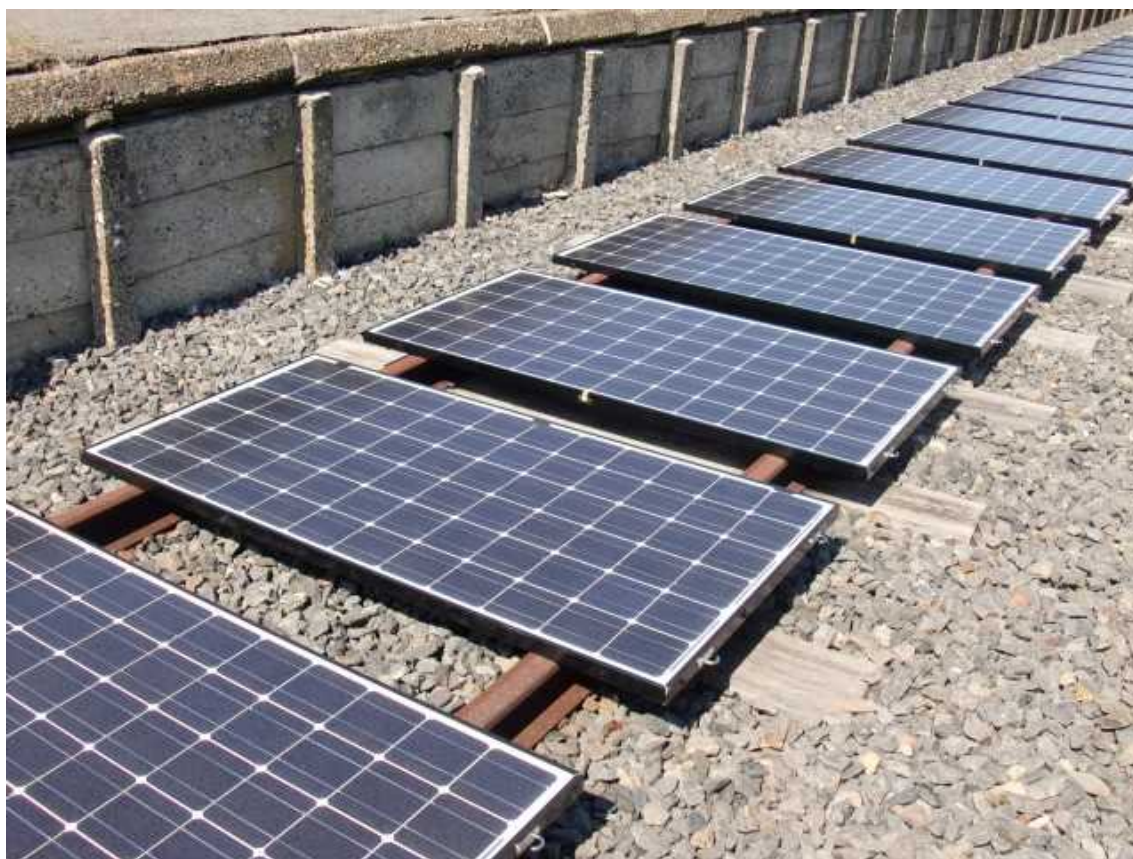
図Ⅲ-2-②-10-25 廃線跡を利用した太陽光発電
