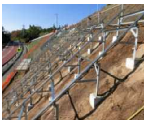
太陽電池モジュール設置前
