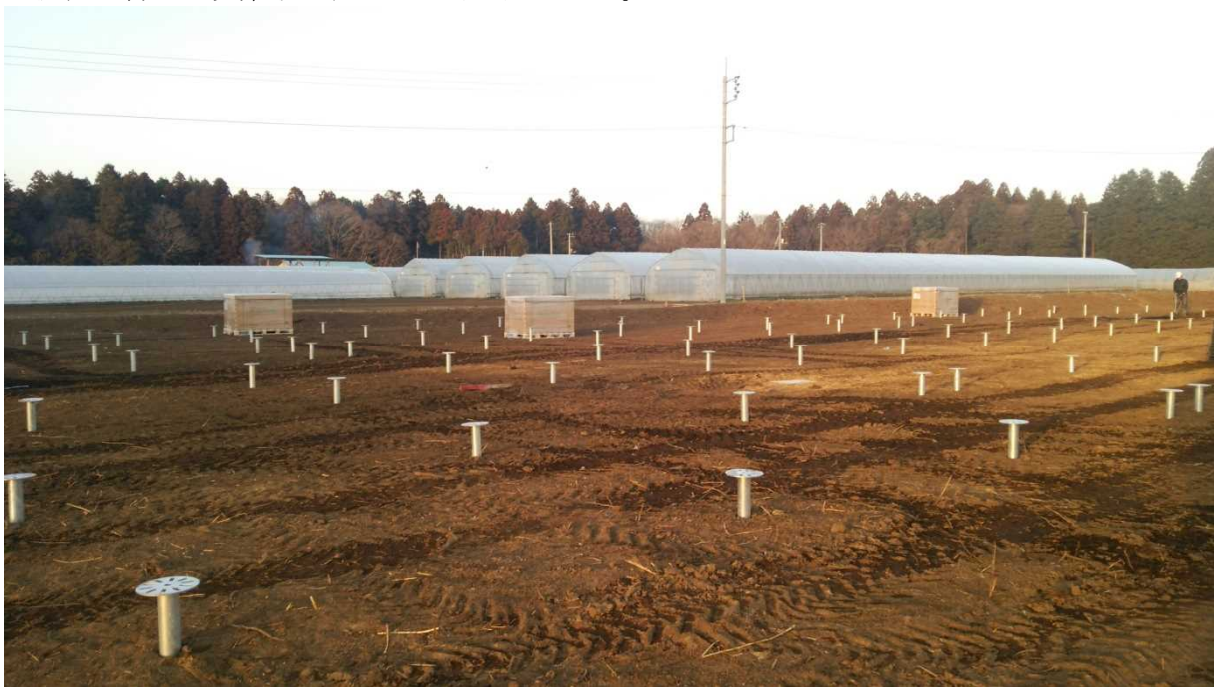
図Ⅲ-2-②-11-12 杭基礎を打ち込んだ状況例
