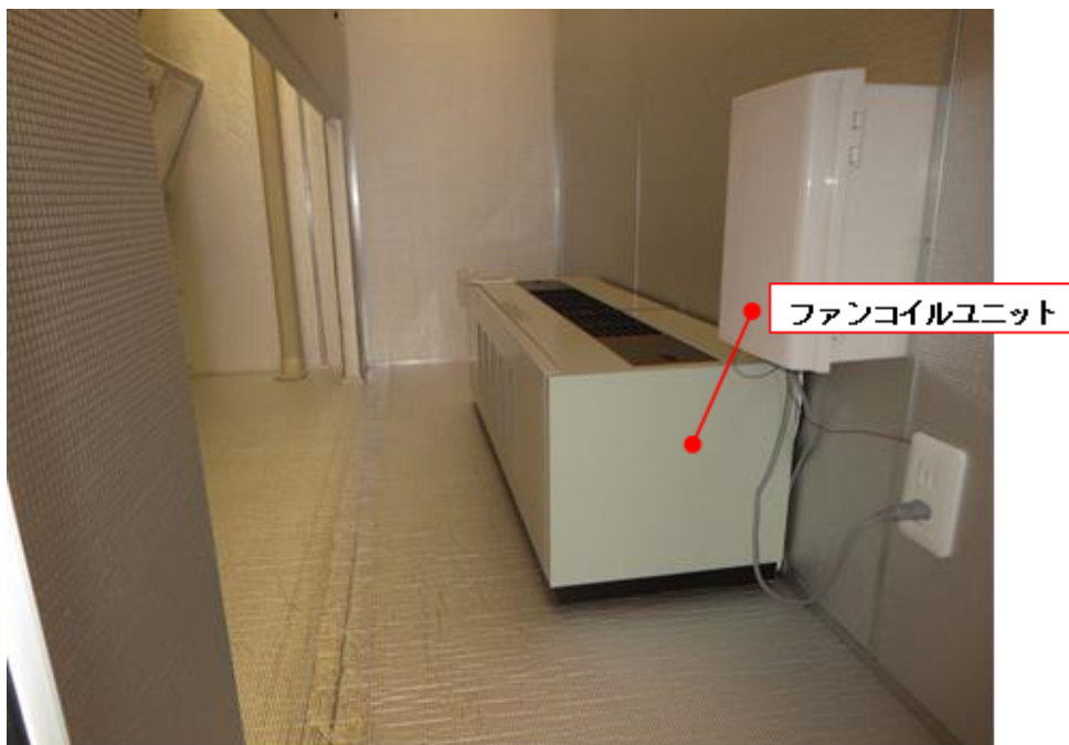
三菱電機冷熱応用システム(株) リビングマスターLV-WLFE-C (1台)
