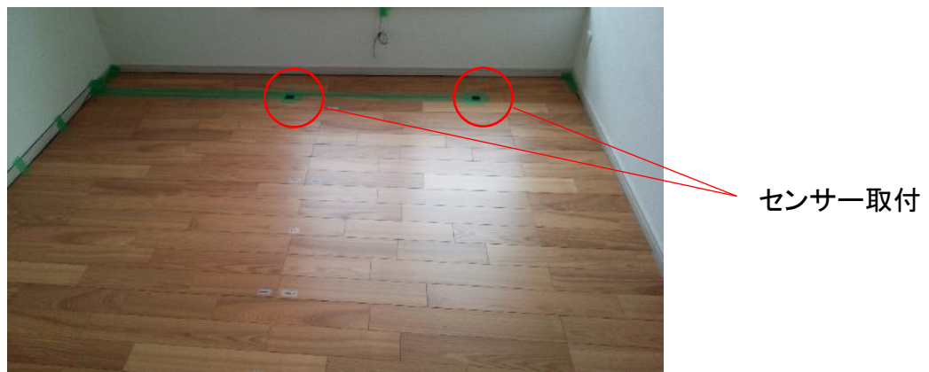
潜熱蓄熱材（PCM床材）施工写真
