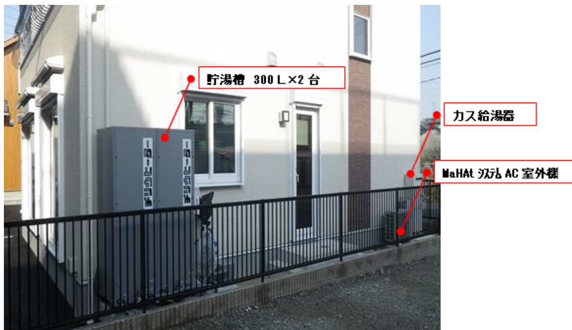
チリウヒーター社製 強制循環式ポンプユニット CSTP305 594×718×1,841 300L (計2台)
