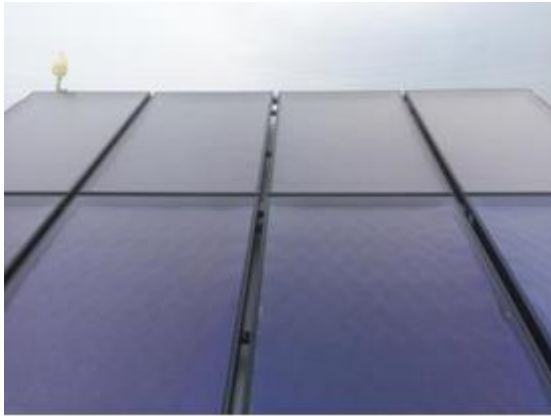
集熱パネル設置写真①
