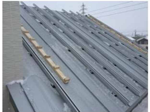
集熱パネル施工写真②
