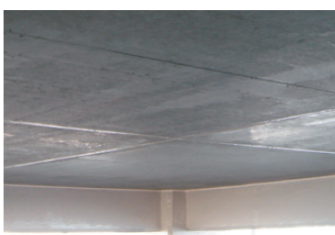
栈橋下面埋設型枠としての利用
