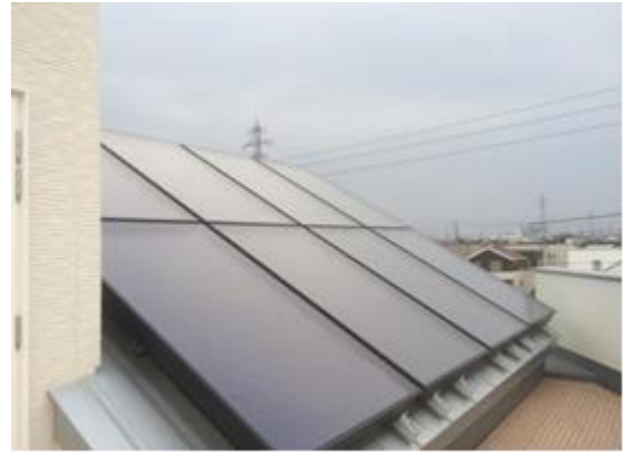
集熱パネル設置写真②
