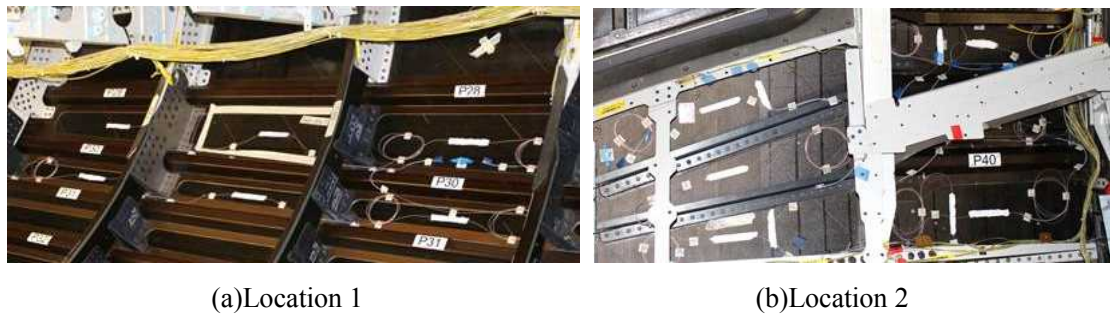
図2.3.4-1 計測線の設置状況
