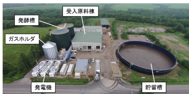
別海バイオガスプラント
