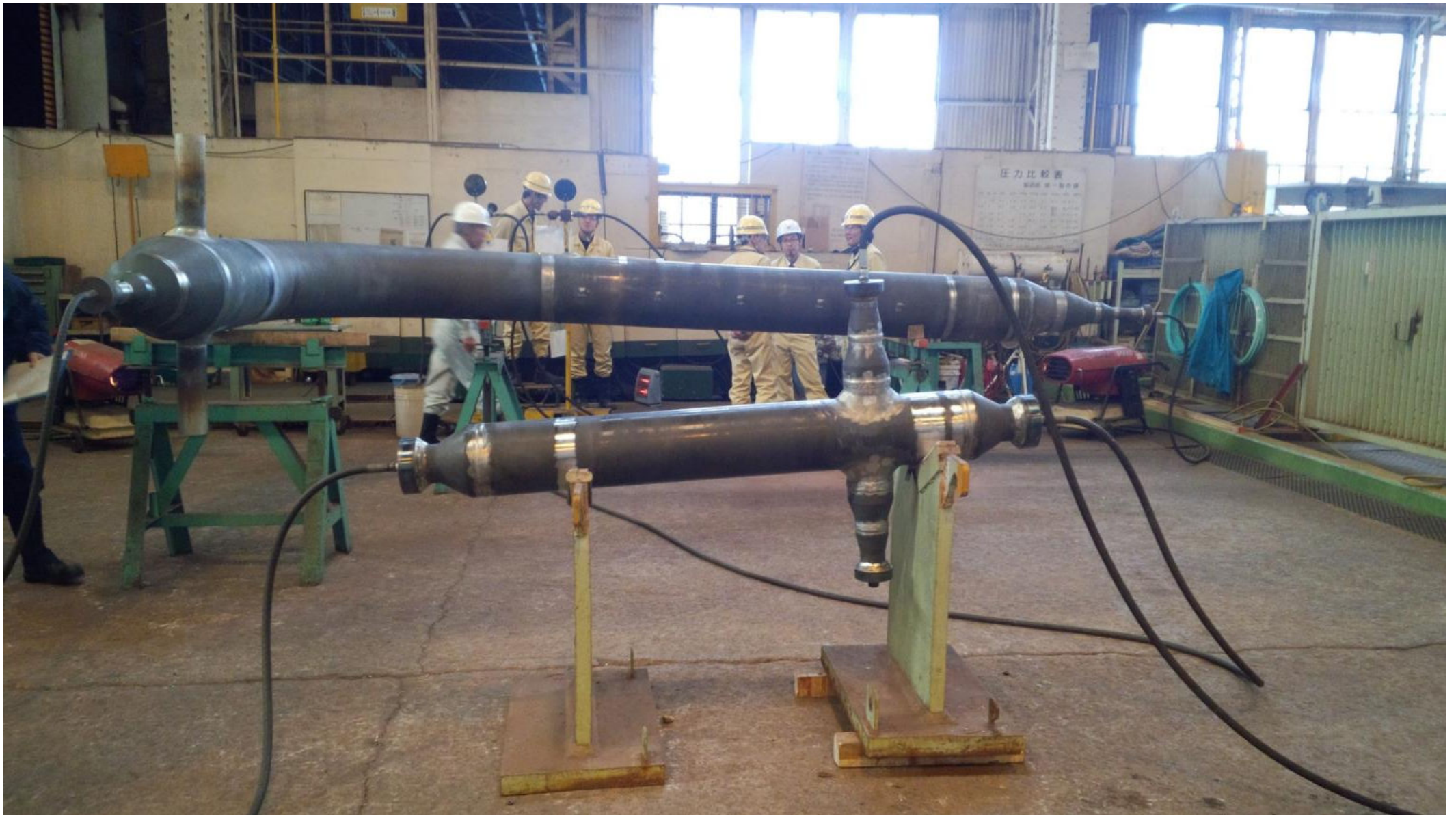
工場内耐圧試験状況
