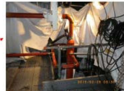
蒸気スプレー式減温器上部(FL20,000)
