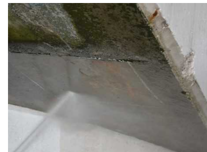
高圧噴射実験（実橋）
