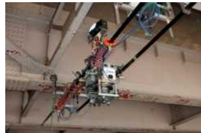
写真: 橋梁ロボット移動状況
