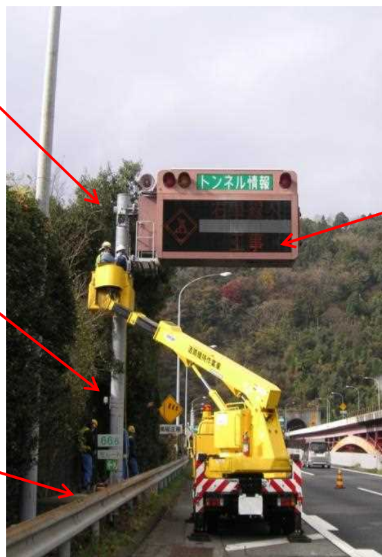
情報板全景(設置作業時)
