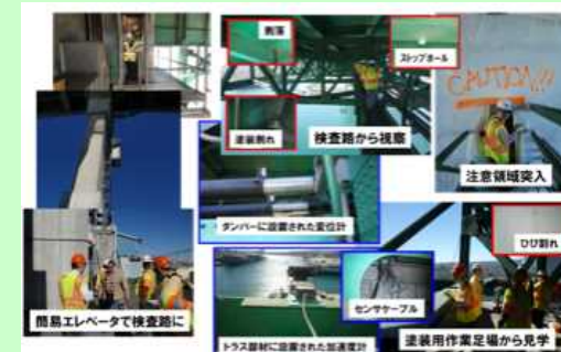
写真6 Vincent Thomas橋検査路からの調査の様子
