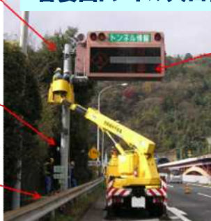
情報板全景(設置作業時)
