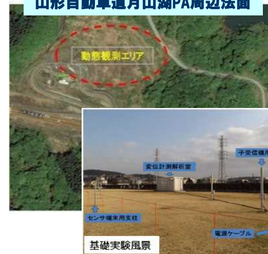
山形自動車道月山湖PA周辺法面
