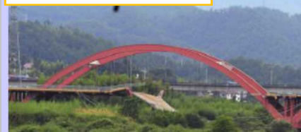
中国 過積載車両による橋梁の崩壊
