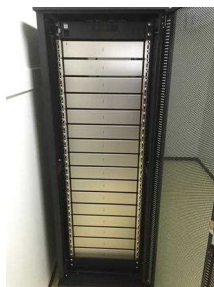
大阪府立大学における蓄電池システム(リチウムイオン)
